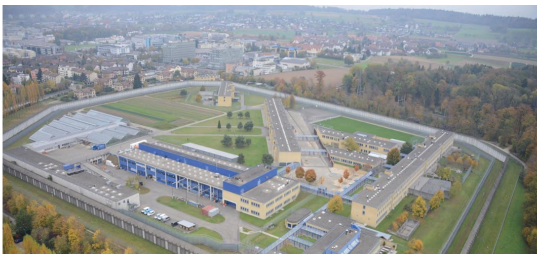
Die Justizvollzugsanstalt Pöschwies ist die größte geschlossene Justizvollzugsanstalt der Schweiz. Sie befindet sich in Regensdorf im Kanton Zürich.
